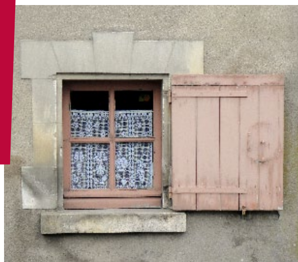
Fenêtre secondaire : quatre carreaux sur un vantail unique
