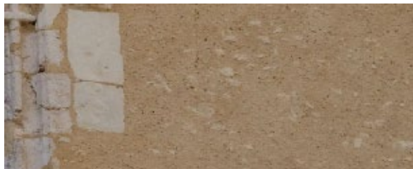
Mur restauré enduit à la chaux et pierres de taille apparentes
