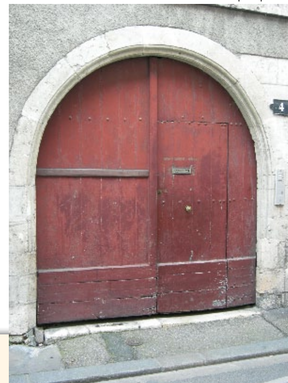
Porte charretière avec porte piétonne
