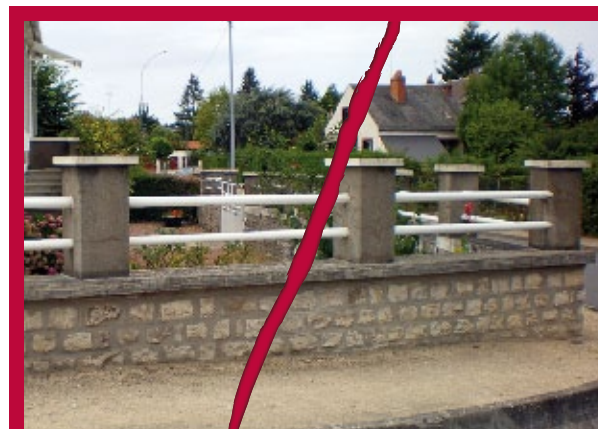
À éviter : clôture en ciment et potelets
