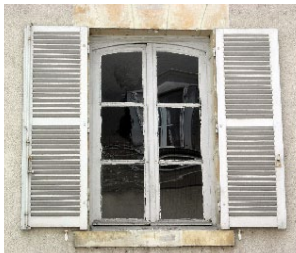
Fenêtre à deux vantaux ouvrant à la française, trois grands carreaux par ouvrant, volets persiennés
